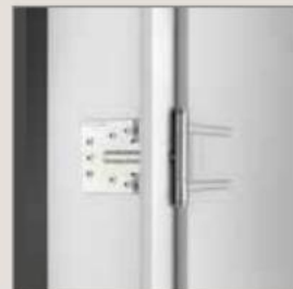
Curelele de siguranță ancorate în zidărie îngreunează deschiderea.
