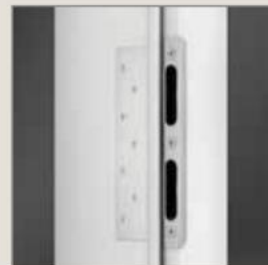
Placa de blocare a ușii este fixată ferm cu șuruburi pe tocul ușii și pe perete.
